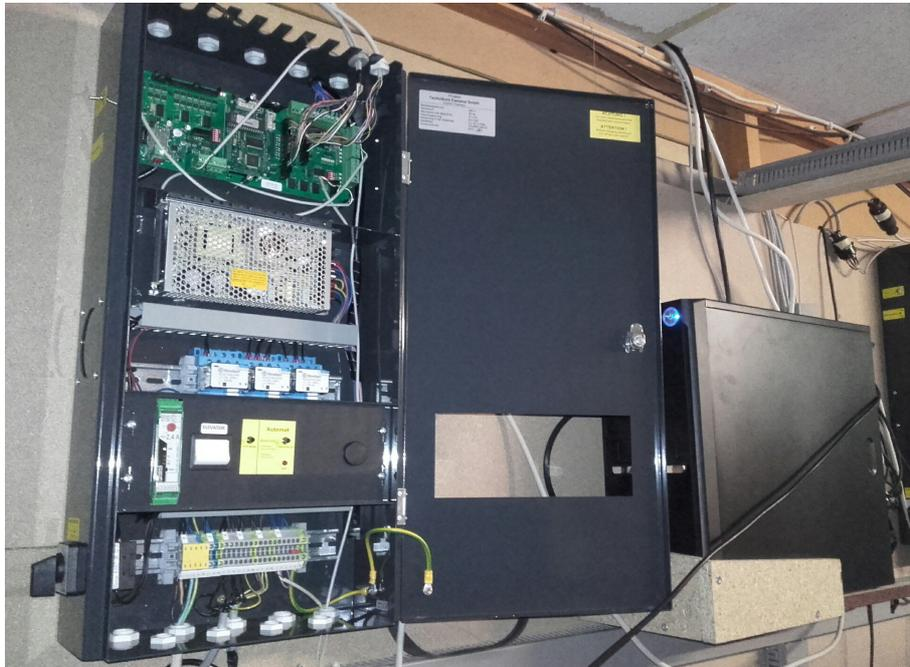
Optika2 unterstützt die Kamenz-Seilmaschinensteuerung. Diese Steuerung bietet zur Ansteuerung 2 serielle RS232 Schnittstellen, welche einfach am Optika-2 angeschlossen werden.
